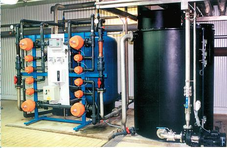
Технологии ионного обмена AquaHard® основаны на применении синтетических материалов – ионообменных смол для процессов селективного удаления растворимых солей, присутствующих в природных водах. Умягчение, декарбонизация, деминерализация – это процессы, в которых используются технологии ионного обмена.
