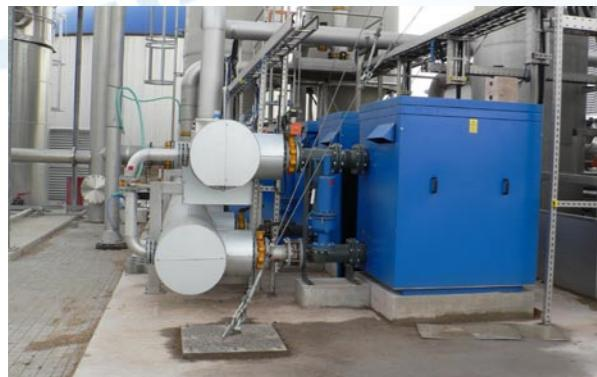
Новые винтовые воздуходувки Lutos предлагают комплексное решение, в которое входит винтовой элемент повышенной эффективности, TEFC IP55 электромотор, редуктор. Конструкция без проблем переносит транспортировку и рассчитана на простую установку на объекте. Благодаря новым технологиям существенно снижен уровень шума при эксплуатации.
